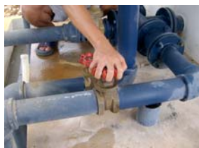
รูปที่ 58 เปิดประตูระบายน้ำทิ้งจากพื้นถังกรอง (ประตูน้ำหมายเลข 4)
