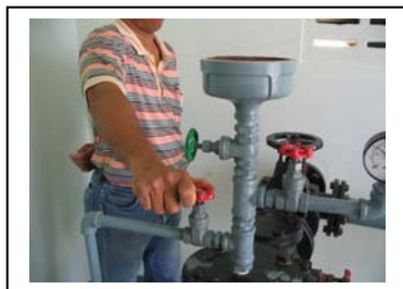
รูปที่ 39 การเติมน้ำเข้าเครื่องสูบน้ำโดยใช้น้ำจากห้องสูง
