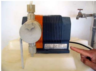
รูปที่ 28 รายละเอียดของเครื่องจ่ายสารละลายคลอรีน
