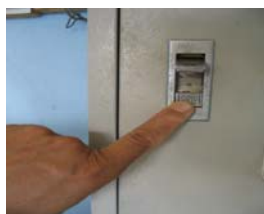
รูปที่ 41 ปุ่มเปิดประตูตู้ควบคุมเครื่องสูบน้ำดี
