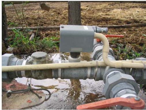
รูปที่ 20 การติดตั้งสวิตช์ไหลที่ปากบ่อบาดาล
