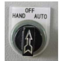
รูปที่ 48 สวิตช์ลูกศรที่ตำแหน่ง “OFF”
