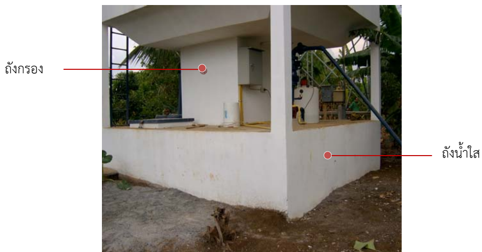
รูปที่ 22 ถังกรองและถังน้ำใส
