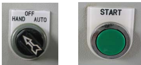
รูปที่ 56 ปิดสวิตช์ลูกศรไปที่ตำแหน่ง “HAND” หรือ “AUTO” และกดปุ่ม “START”
