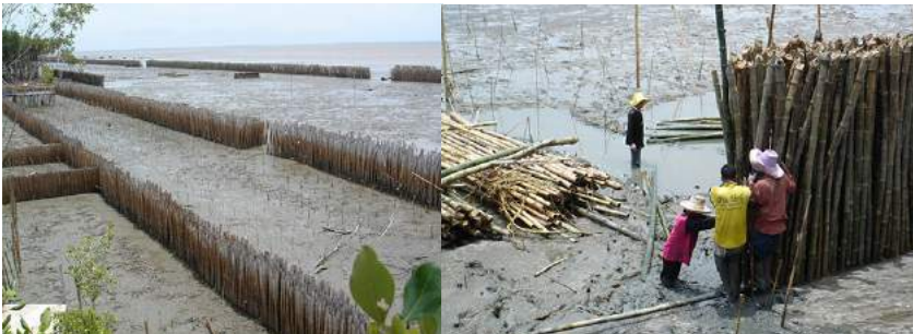
ภาพที่ 14: การสร้างแนวกันคลื่นซัดชายฝั่งเพื่อรับมือกับการเปลี่ยนแปลงสภาพภูมิอากาศชุมชนโคกคาม จ.สมุทรสาคร ที่มา: Blate, G., 2010 (พ.ศ. 2553)
