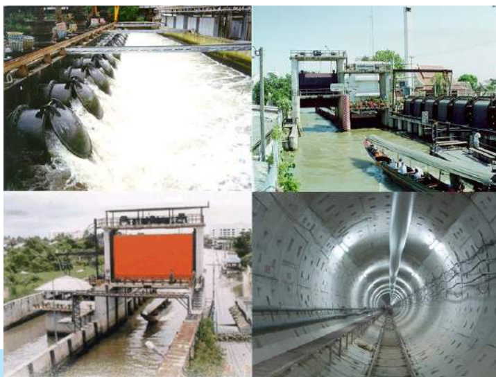
ภาพที่ 16: ตัวอย่างการป้องกันและลดผลกระทบจากน้ำท่วมในกรุงเทพมหานคร (สถานีสูบน้ำ ประตูระบายน้ำ อุโมงค์ยักษ์) ที่มา: สำนักงานระบายน้ำ กรุงเทพมหานคร
